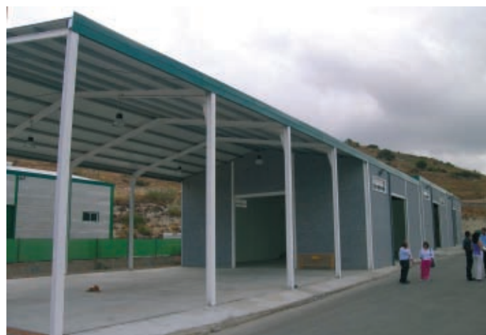
Proyecto de ampliación instalaciones de la Empresa de Gestión Medioambiental de Puente Genil (EGEMASA).
